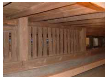
床下施工前写真
