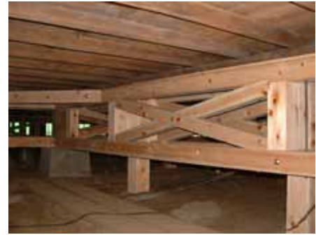
床下施工後写真
