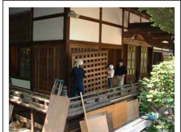
面格子はめ込み作業
