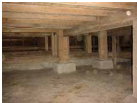
床下施工前写真
