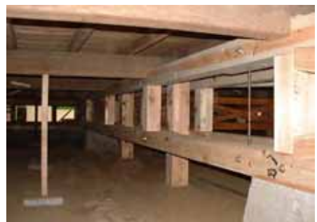
床下施工後写真
