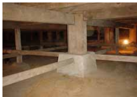
床下施工前写真
