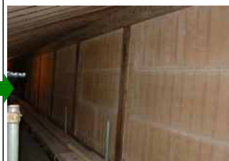
荒壁パネル取付け
