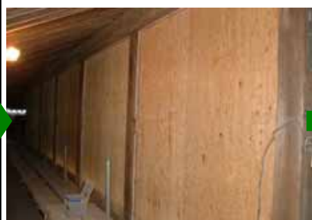
構造用合板取付け
