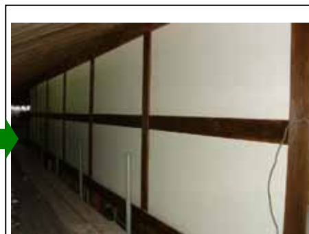
漆喰仕上げの耐震壁完成
