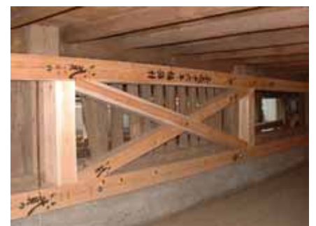
床下施工後写真
