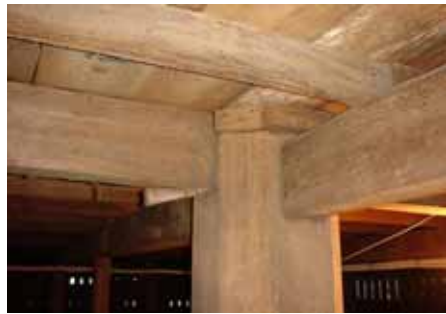
床下施工前写真
