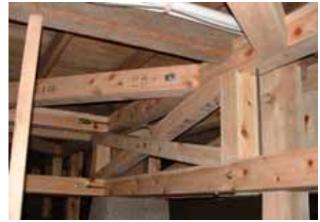
床下施工後写真
